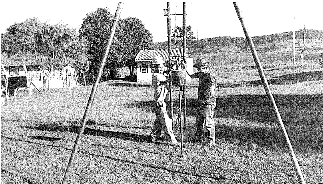
Foto 04 – Continuidade da perfuração. Foto Thiago Colaço.
