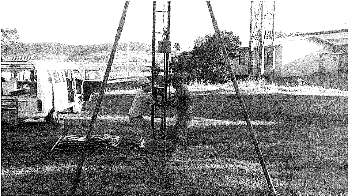
Foto 02 – Início das perfurações do primeiro furo. Foto Thiago Colaço.
